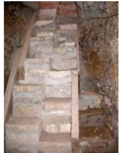
Escalier « pas de souris » (Guy. Fourré)
