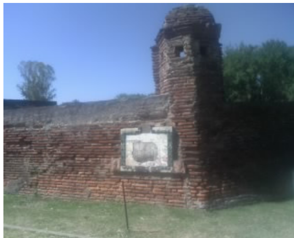
Torreta de observación
